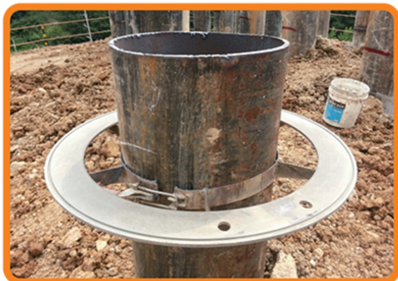
강관절단용 가이드 레일 설치
