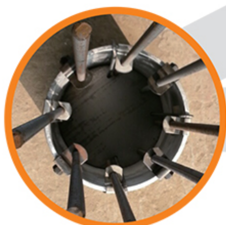
7, 체결구 (미끄럼방지턱)의 보강철근 설치 기초 콘크리트 타설시 속채움 동시실시
